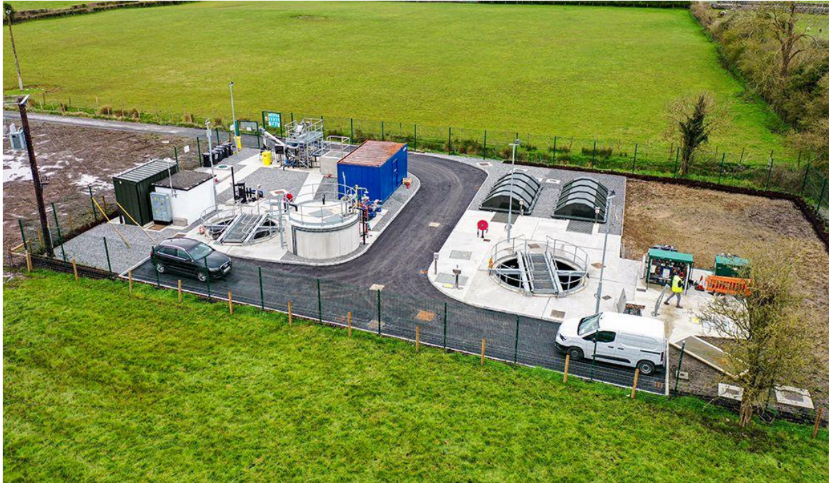
Ionad Cóireála Fuíolluisce Áth Eascrach
